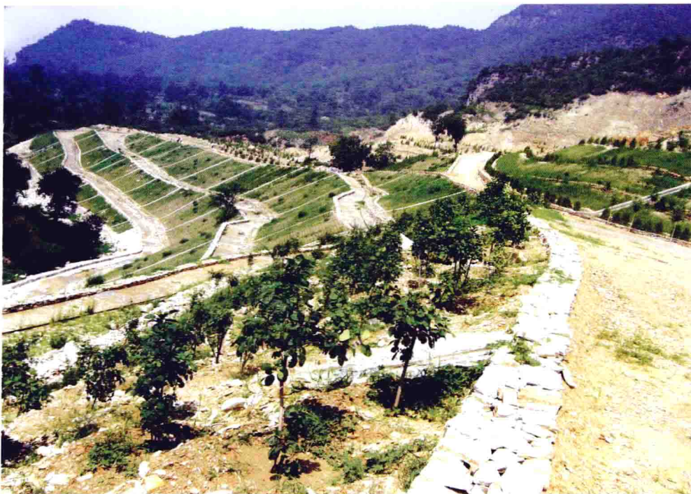
怀柔河北镇红螺山矿山修复改造工程
