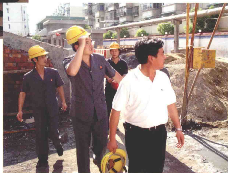
临安市市委常委、常务副市长吴苗强 视察临安法院新大楼工地
