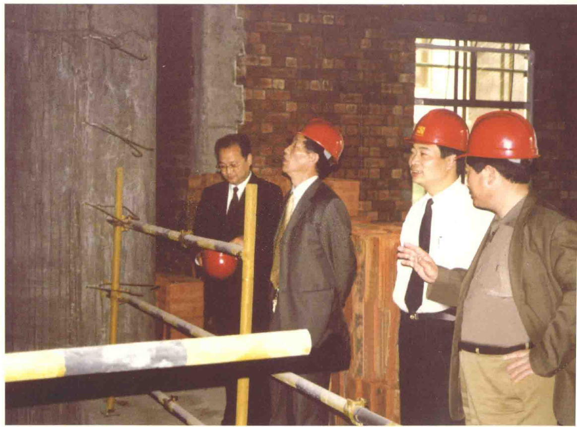
◎ 临安市政协主席方金贵视察临安法院新大楼工地
