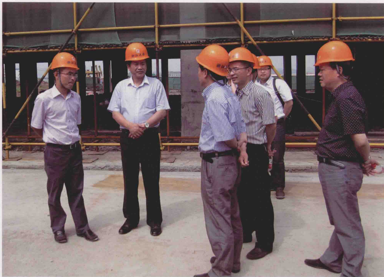
■ 临安市政协主席张金良视察市文体会展中心建设工程
