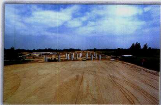
连云港到三门 峡高速公路开封至 商丘段正在施工。
