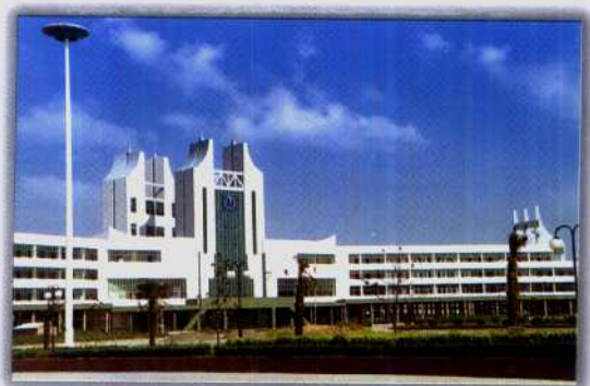
位于京九线上 的商丘南站
