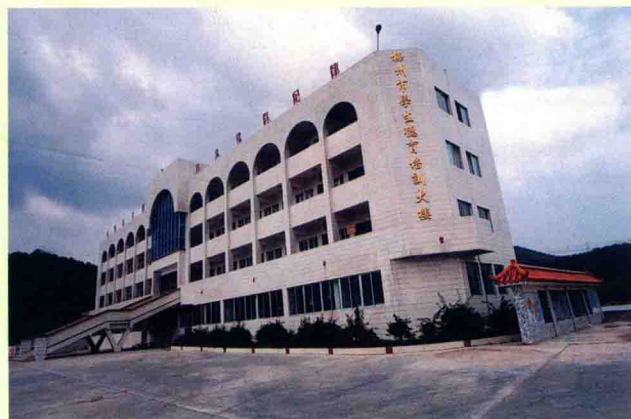
图为筹集200多万元兴建的梅州市学生德育基地培训大楼
