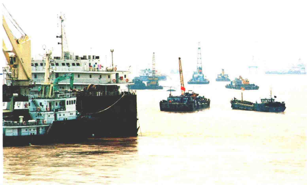
北导堤施工场景
