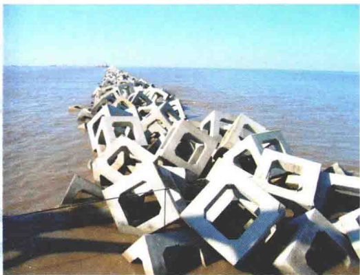
单个重量为 14.4t 的空心方块斜坡堤。六面空心，主要用于导堤。
