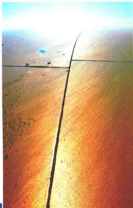
向东延伸的北导堤
