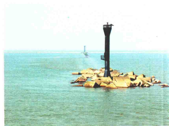
北导堤 N10 丁坝，长江临海第一座丁坝。
