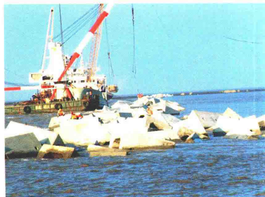
单个重量为 19t 的空心方块斜坡堤。两面空心，主要用于丁坝。
