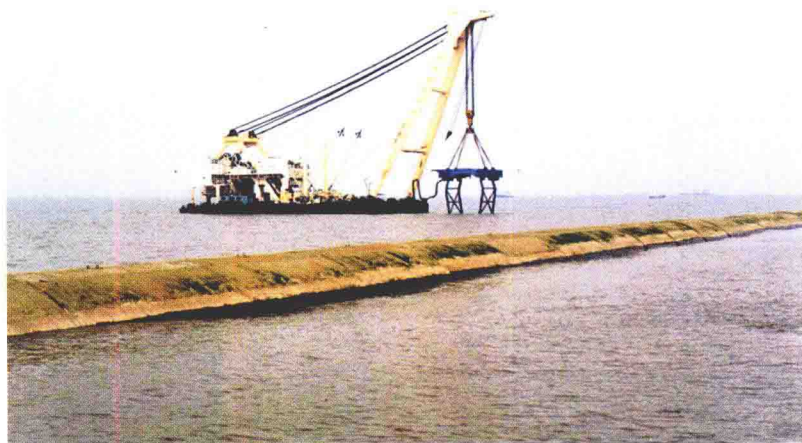
充砂半圆体混合堤（单个重量 450t）
