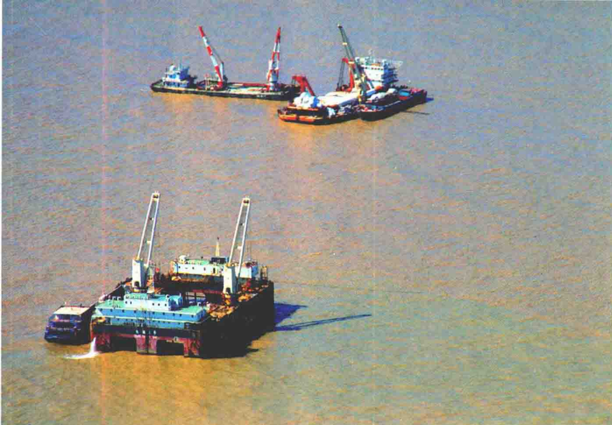
铺排、抛石和整平
