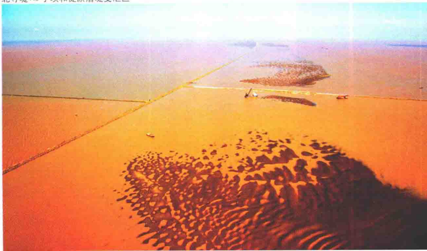
北导堤 N5 丁坝和促淤潜堤交汇区
