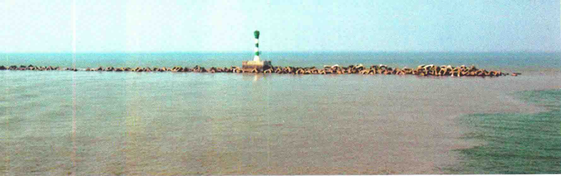
北导堤堤头及灯桩。由此至横沙岛，导堤蜿蜒 49.2 公里
