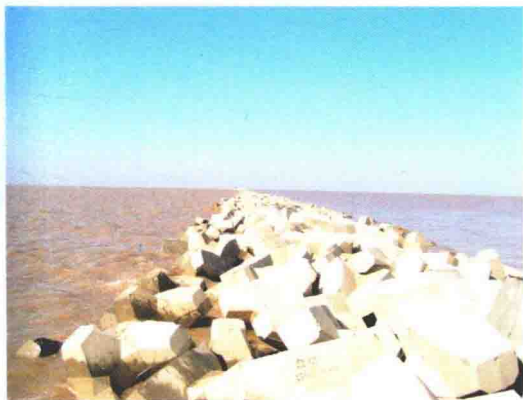
袋装砂堤心钩联块体护面斜坡堤
