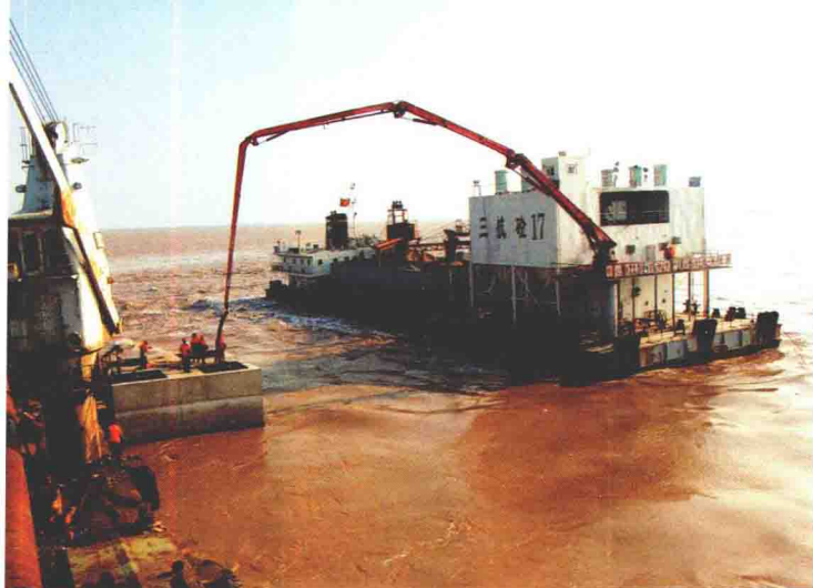
混凝土搅拌船浇注灯桩承台
