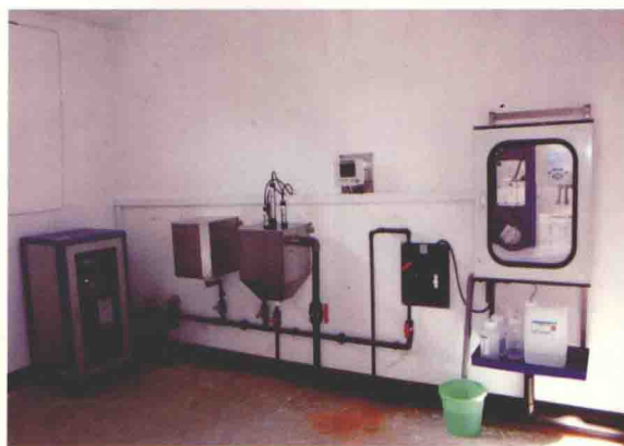
第二自来水厂水质自动监测系统
