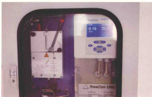
第二自来水厂水质自动监测系统
