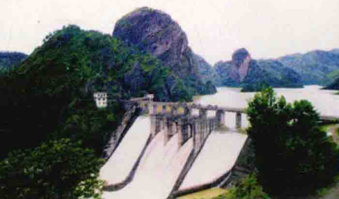
△装机容量9千千瓦的军潭电站
