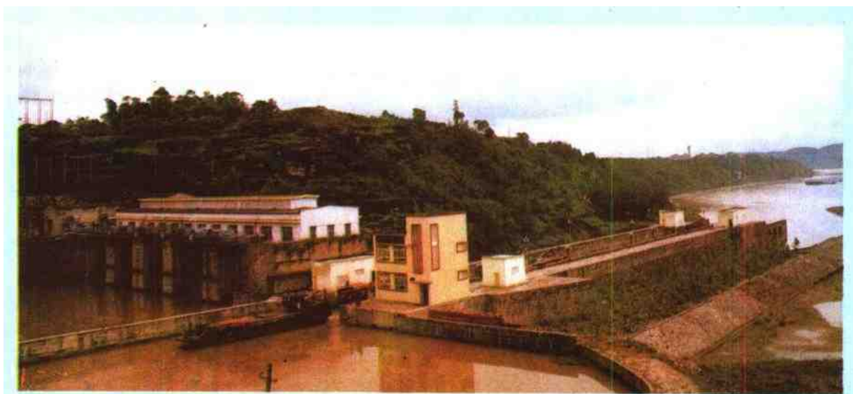
潼南县境内涪江三块石闸船，投资1100万元，经三年施工，1987年建成，使断航十多年的涪江，重新通航。
