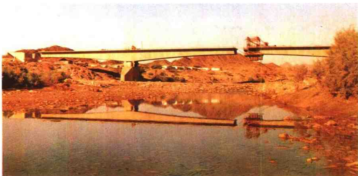
南也门洼地巴那大桥施工
