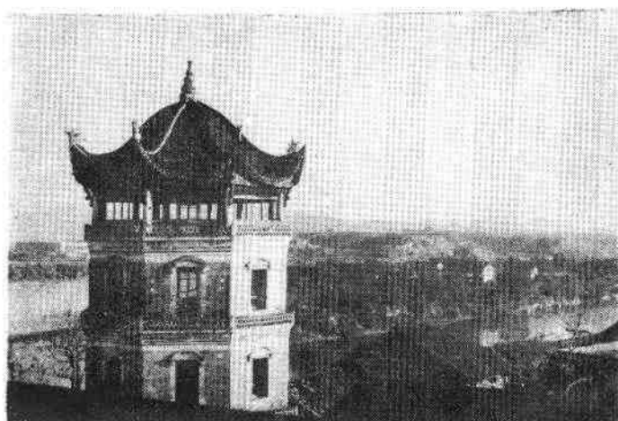
耒阳城摄影（八角亭一角）
