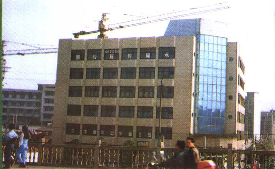
醴陵市建设局大楼（谢磊 摄）
