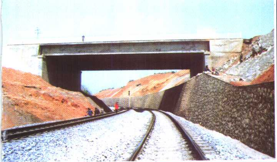
四坑立交桥 (浙赣铁路复线醴陵指挥部供稿)
