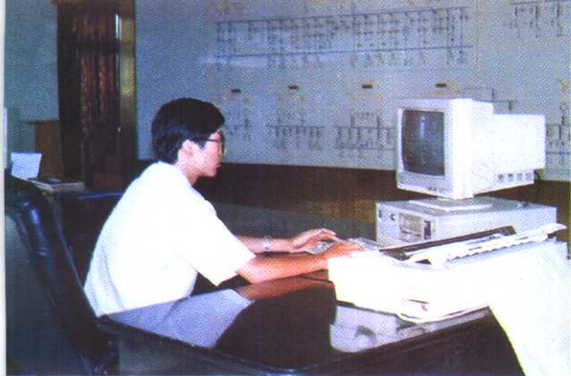
醴陵电力局电脑控制室 (谢磊 摄)
