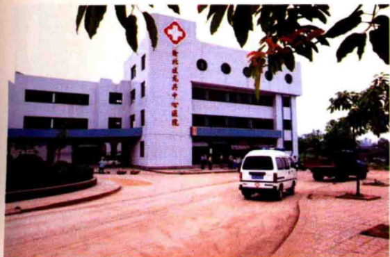
↑ 渝北区龙兴中心医院门诊综合楼。
