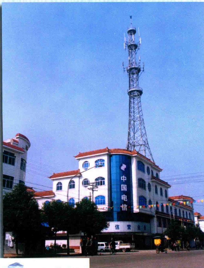
● 周巷电信大楼
