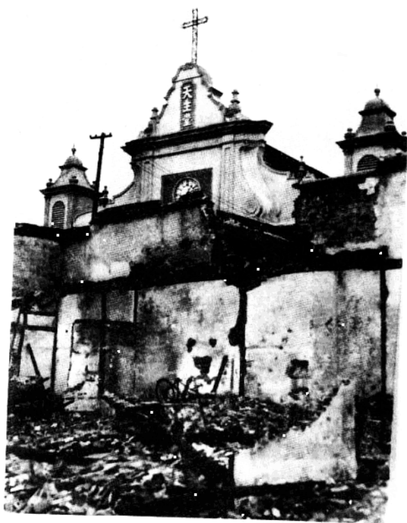
日寇轰炸后，董家渡天主堂门前的残垣断壁。
