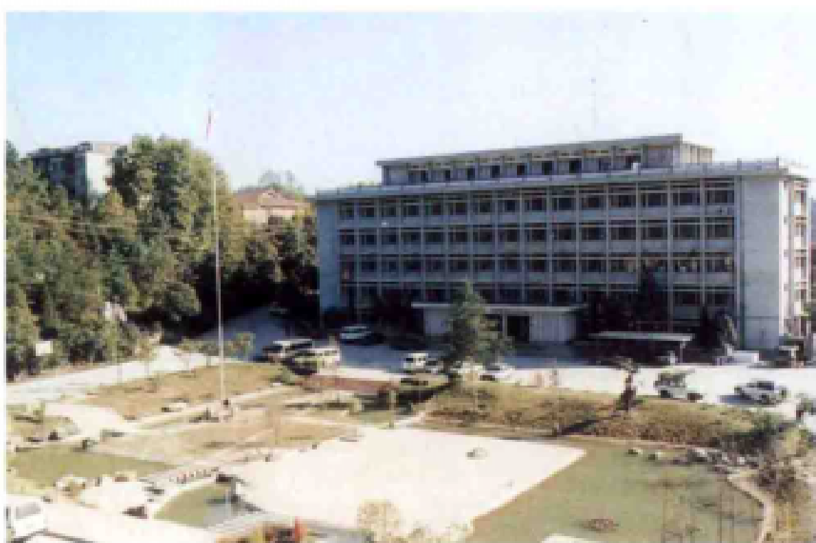
市政府办公楼
