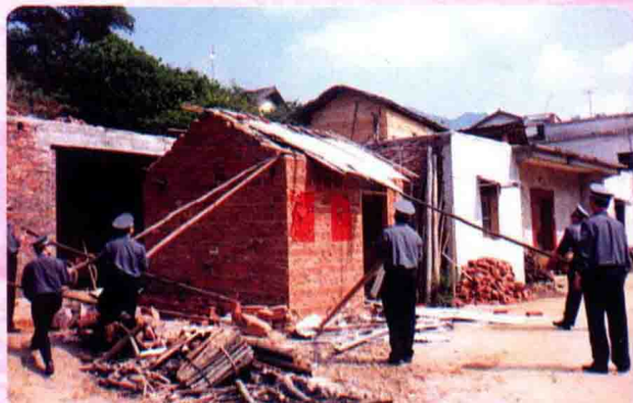
依法拆除违法用地上的建筑物
