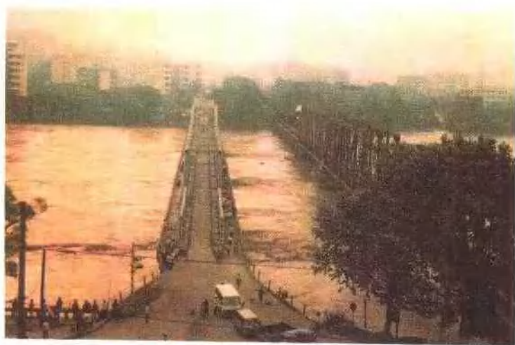
7月6日正在猛涨的洪水，已封住了桥墩， 桥上无法通行。
