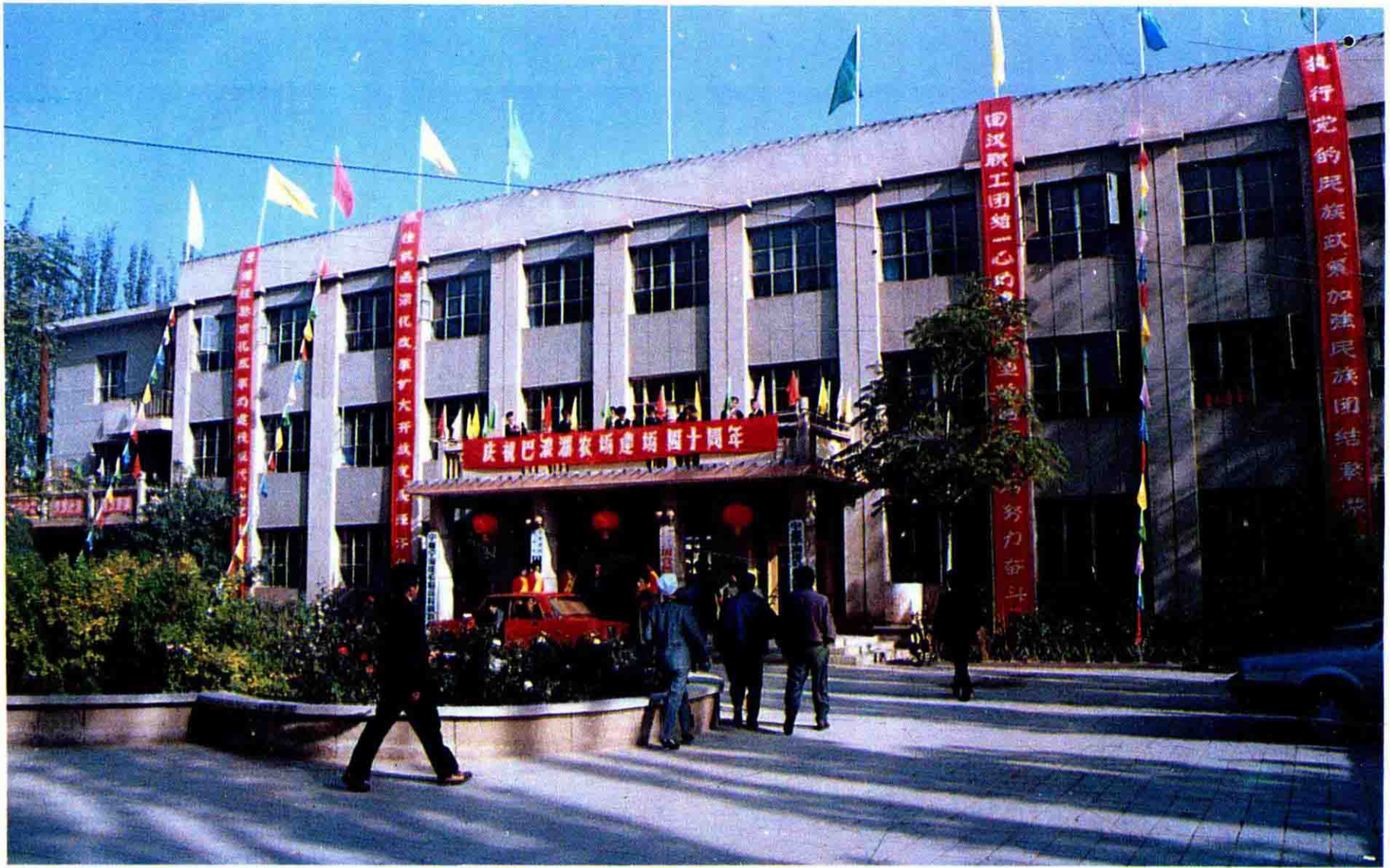
场部机关办公楼
