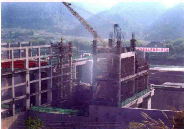
正在兴建中的三龙水电站
