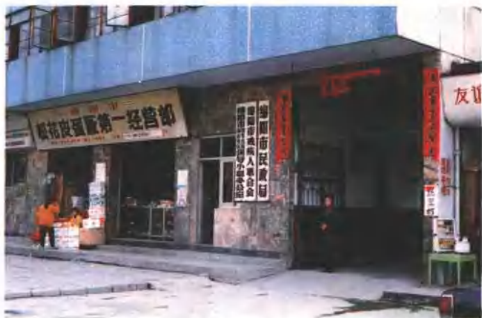
一九八六年竣工的绵阳市民政局办公楼（南河路12号）
