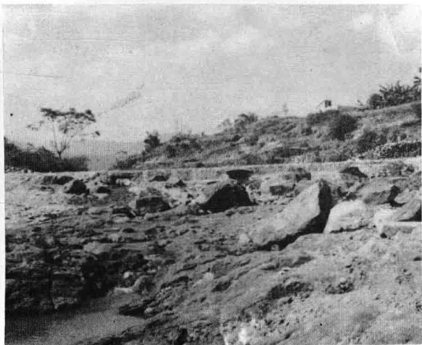
由公路接通老屋、歧洋、禾丰等自然村的“上溪坝水面桥”全长40米宽3米
