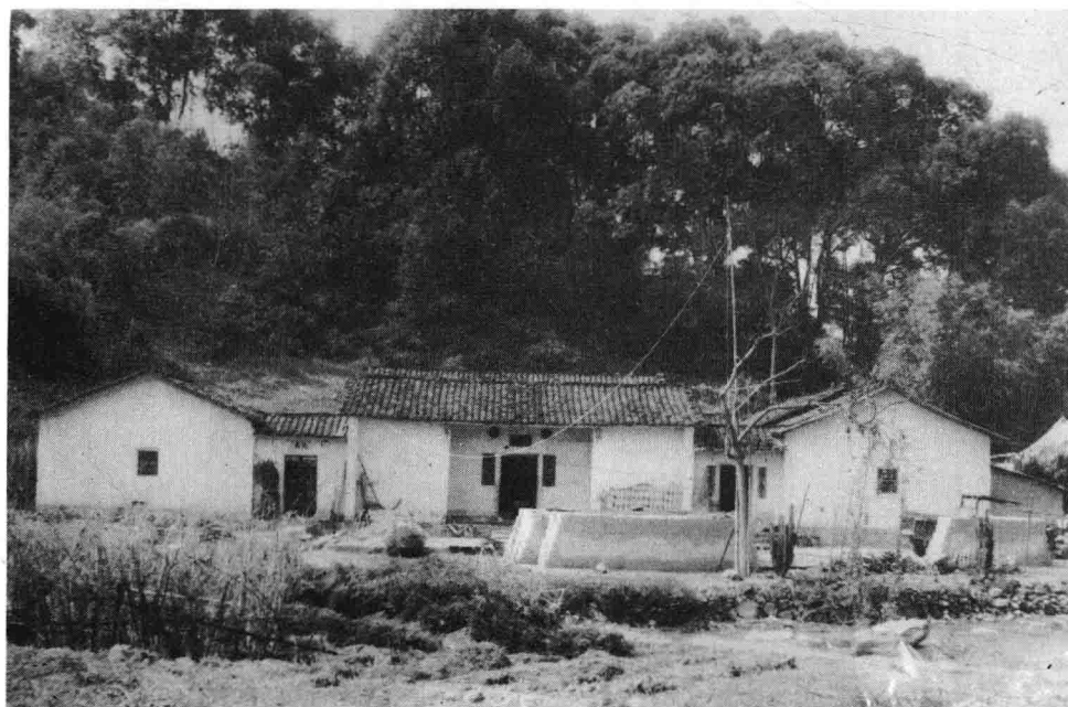
江坑石头坑八世祖竹园公创建的德庆堂旧址
