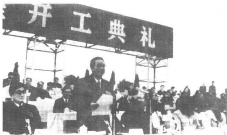
1994年12月14日，李鹏总理宣布：“长江三峡水利枢纽工程今天正式开工！”
