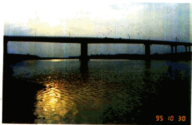
距縣城四公里的交通咽喉 ——馬背嘴公路大橋
