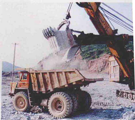
△斗容 4 立方米的电铲与载重 42 吨的矿用大车作业现场
