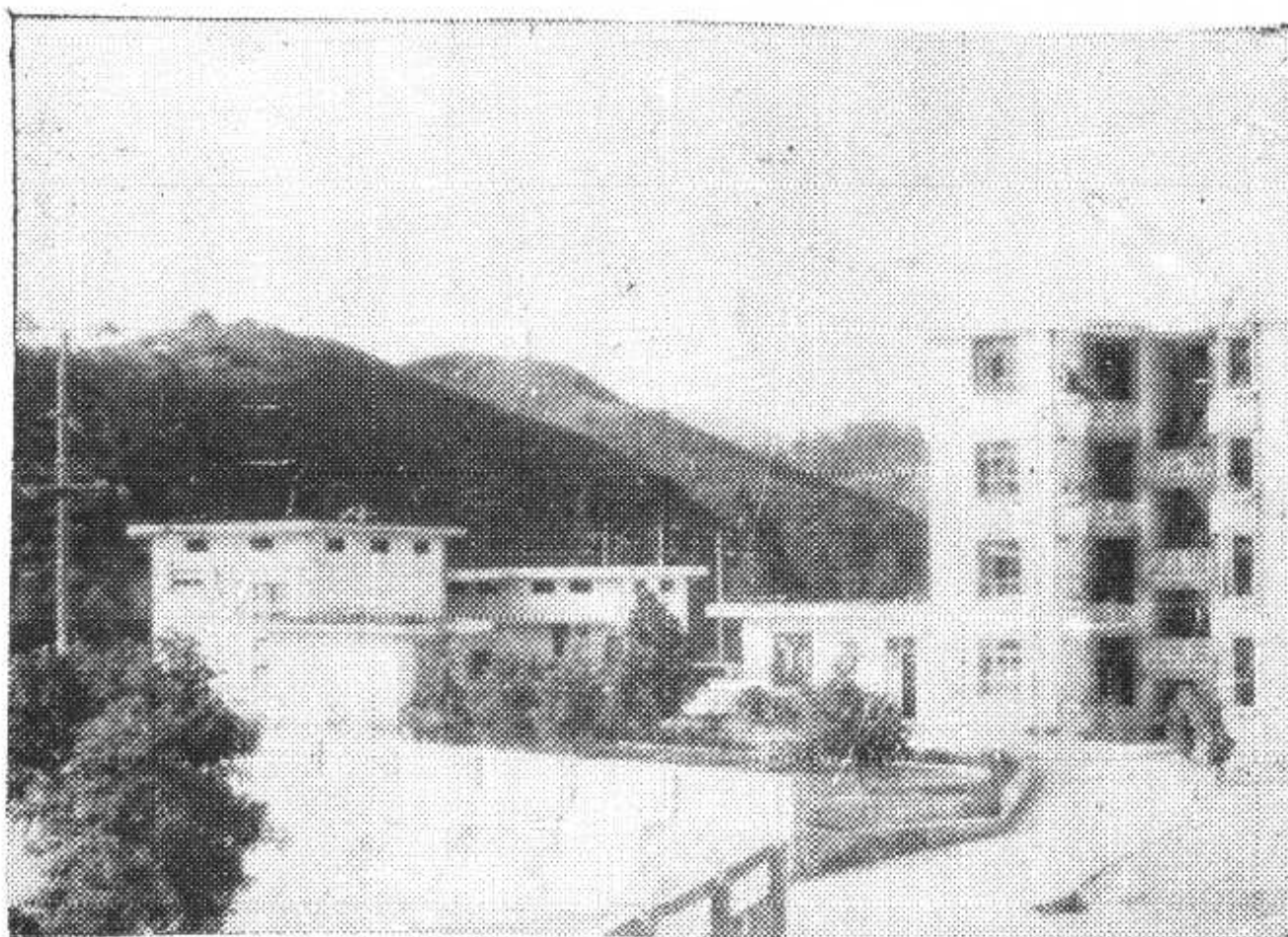
可从10KV升至35KV的夏阳乡供电所升压站 李春华 摄
