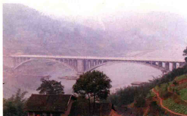
赤水市大同大桥
