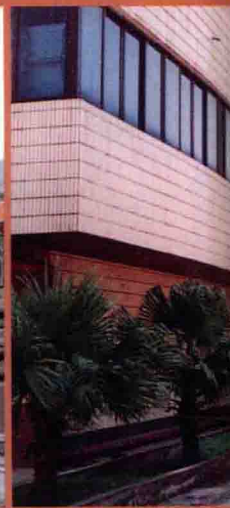
整洁干净的厂区
