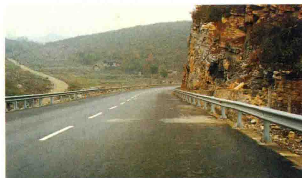
贵遵高等级公路的路基路面工程
