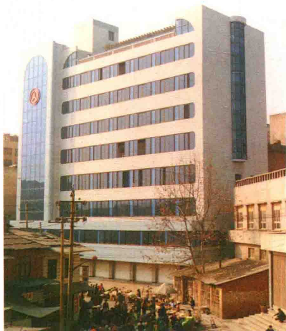
交通局办公楼
