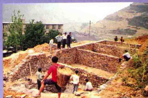
“渴望工程”水池施工现场
