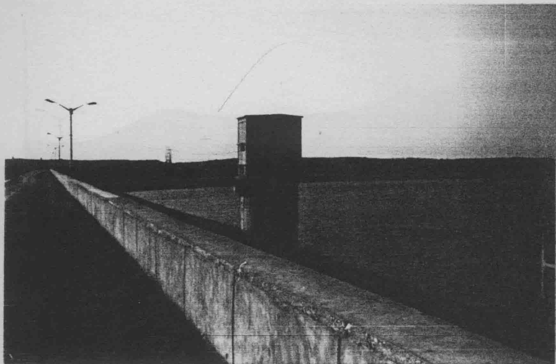
黃坡水庫大堤
