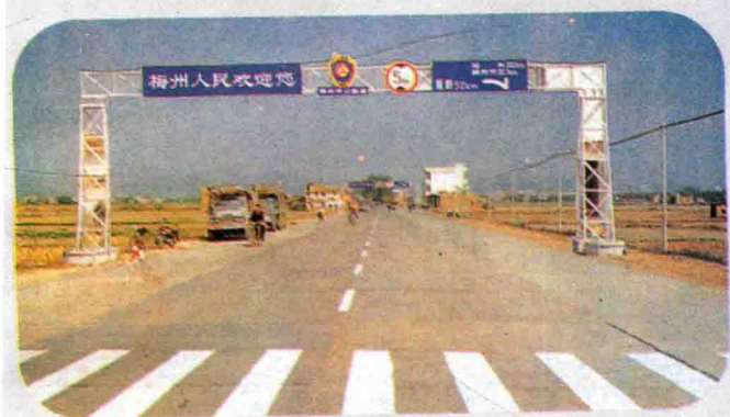
▲ 贯通梅州的国道公路
