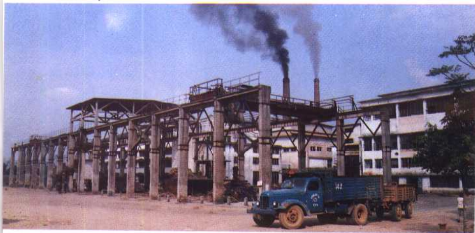
图为屯昌县糖厂一角
