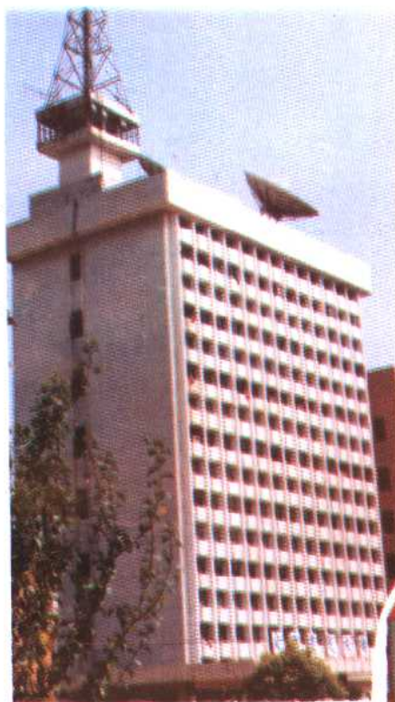
△广播电视大楼
