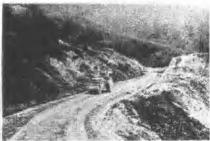
正在施工的水旧公路之竹丝梁
