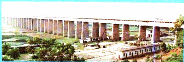
雷州青年运河新桥大渡槽
