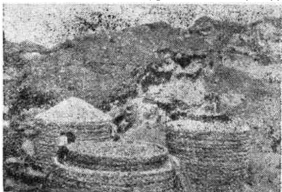
周口店的石灰窯。左邊的窯已封好了窯頂；右邊的窯已將窯頂碼好，正在封窯頂；中間的窯，在倒圍土，正在裝窯。皮之外仍須捆上粗繩，窯皮一直砌到窯頂爲止。
