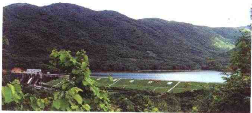
三亚市水源池水库
