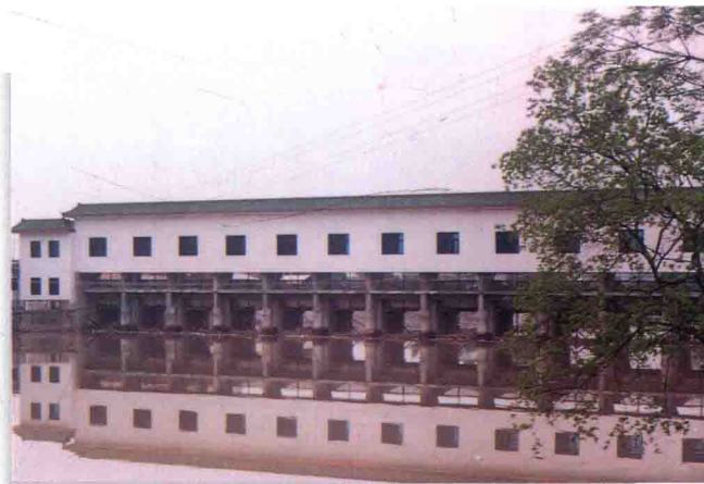
安全加固后的望江狮水闸
