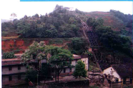
图为二电站全景
