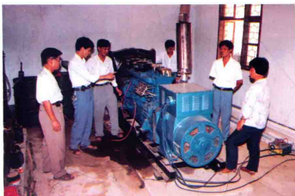
支部书记朱云标（左二）、管理区主任王佑新在柴油发电机组安装现场。
