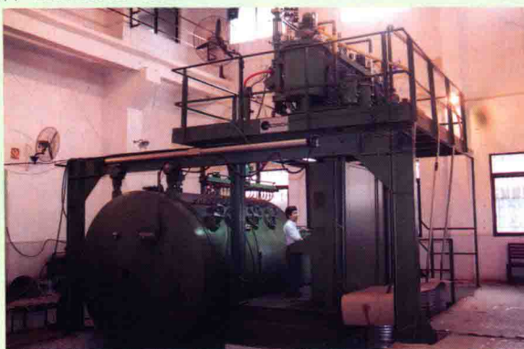
兴宁变压器厂引进德国 HEDRICH 公司先进设备——真空浇注设备。
