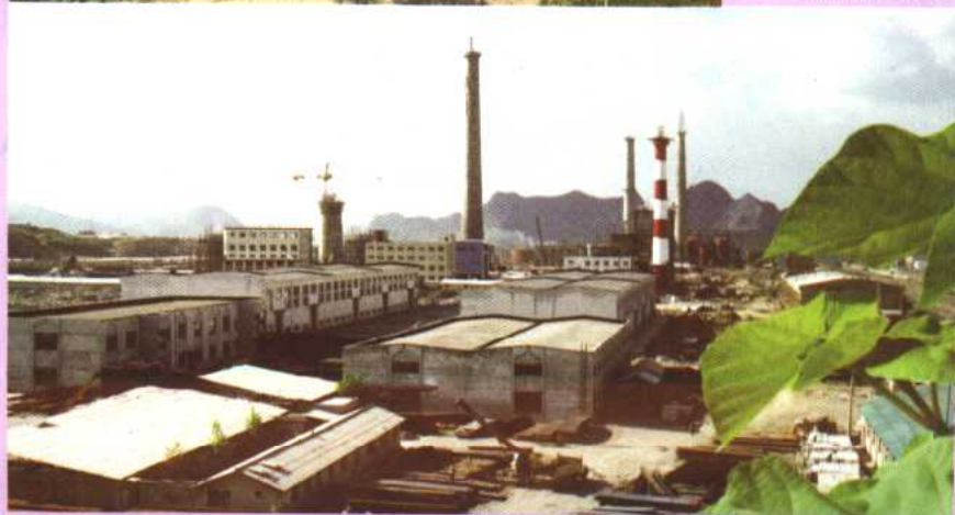
▼ 建设中的瓮福磷肥厂
