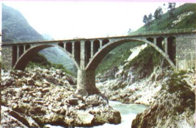
▲ 福开公路天生桥
