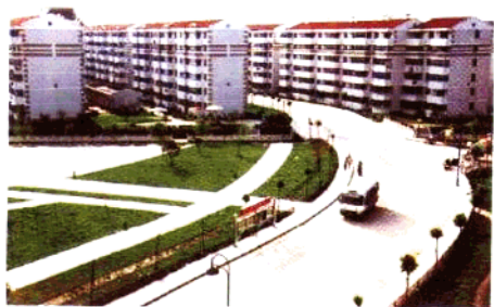
◀莲花住宅小区一角
