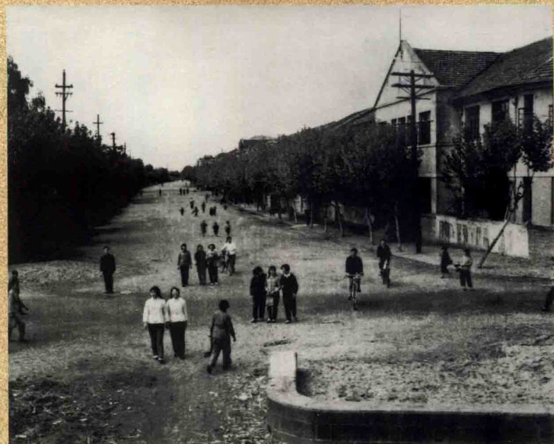
建国初期正在拓宽的沿河路。沿河路旧称“河街”，政府拆除河街沿江修筑河堤，至1956年底建成能并行3辆汽车的沥青路面，这是当时全区的主要道路和风景区之一。
