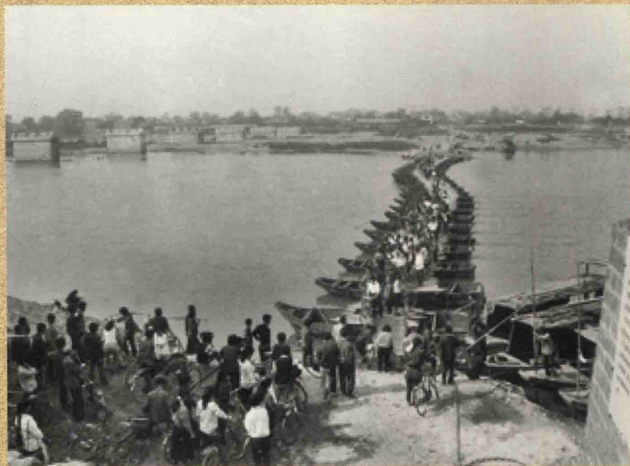
90年代初的汪家园浮桥，旁边为正在修建的胜利大桥。
