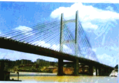
采用 OVM 拉索锚具建设的柳 州壶西大桥
