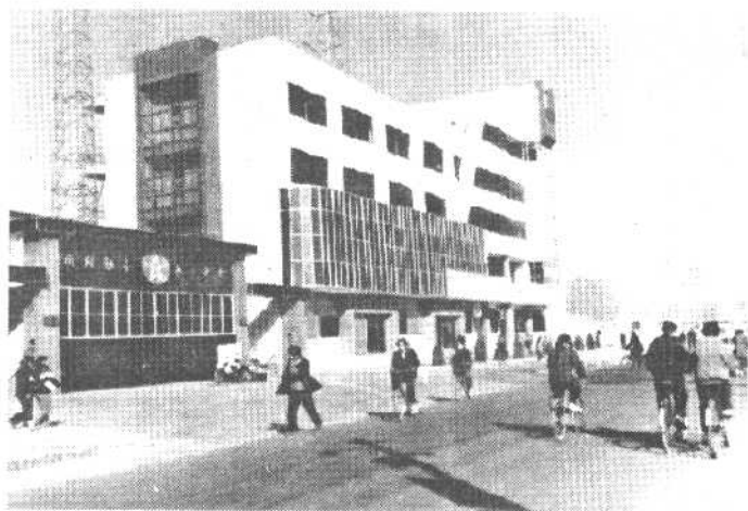
邮电局程控大楼
