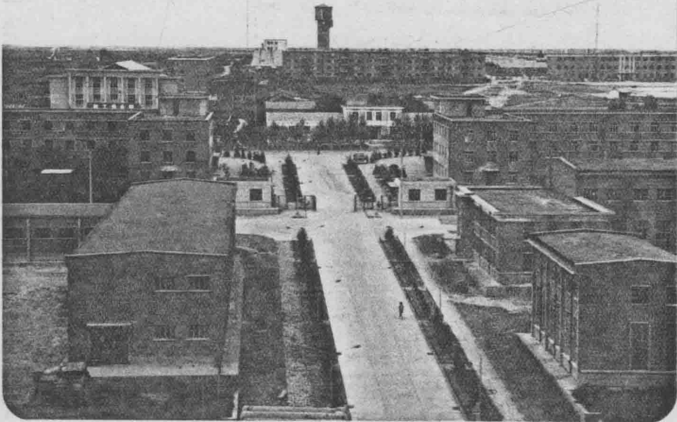
新华发电厂厂区一角
