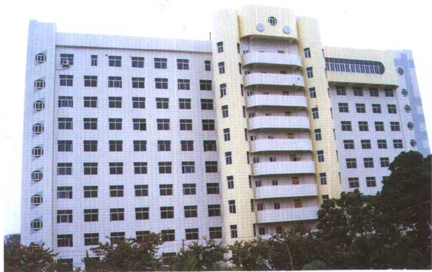
▲湛江市四建公司承建的湛江农垦中心医院住院楼,1995年被评为市优良工程。
