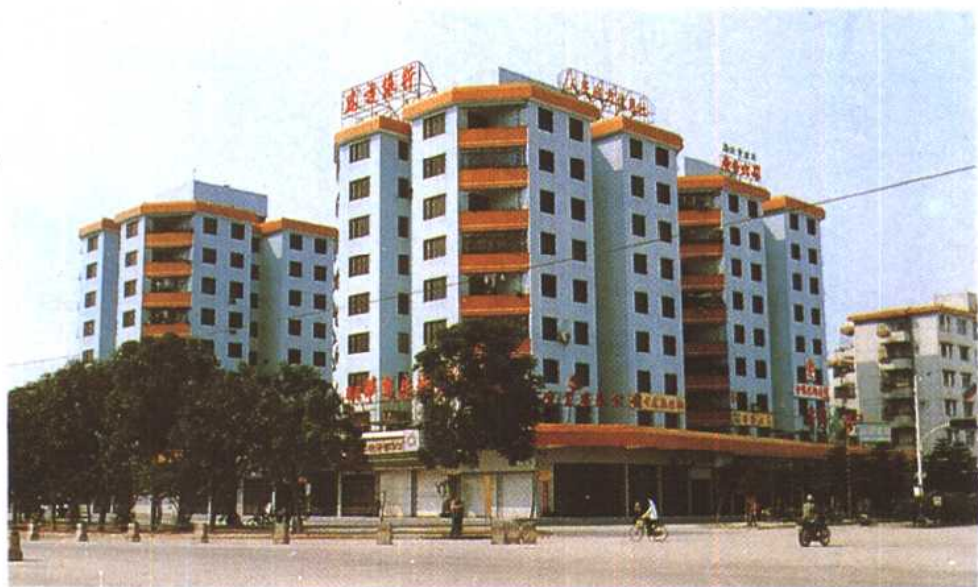
▲湛江市十建公司施工的湛江市开发区泉庄D座住宅楼,获国家建设部优质样板工程奖。
