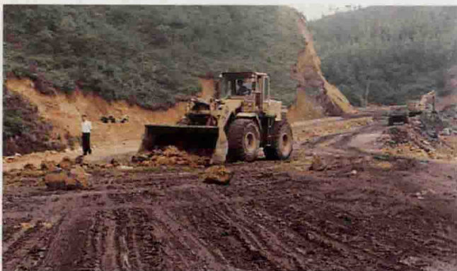
△大梅线公路改造机械化施工现场
