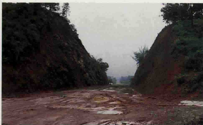
△劈山开路，深山有坦途。图为省道大梅线大麻段公路改造路基工程
