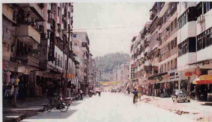
△正在改造中的万川路商业样板街街道
