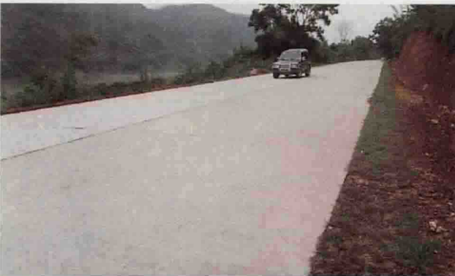
△县公路局在全市率先推广种植路肩草，绿化美化公路，全面提高养护质量。图为省道大梅线三河路段
