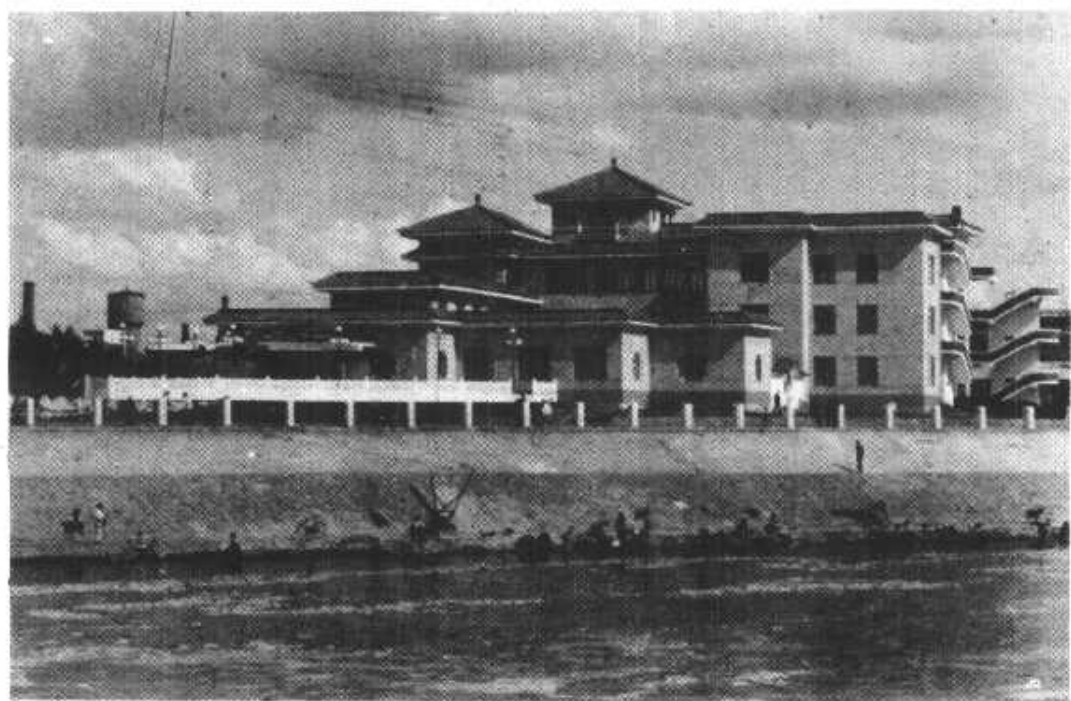
富锦江堤指挥部建造的办公楼
