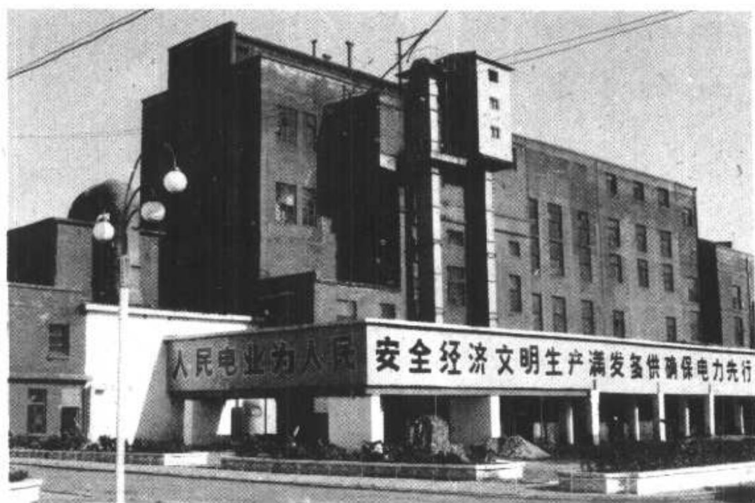
热电厂厂房一角
