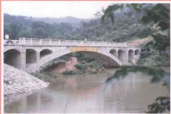
清泉村曾棚大桥
