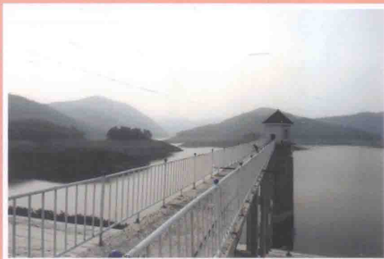
整修后的北山水库大坝
