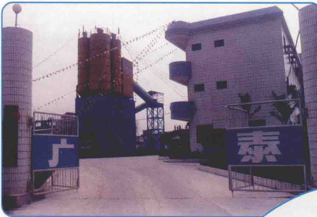
广泰混凝土公司
