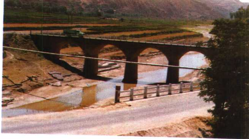
上堡子公路桥与寇沟门公路桥 黄克义 摄影
