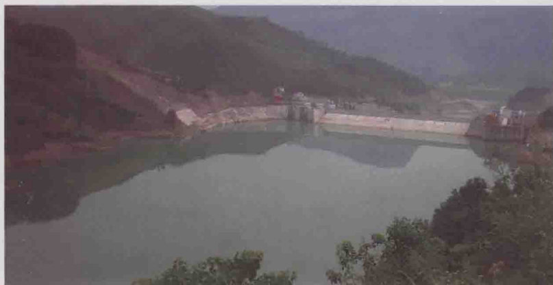
鱼塘电站库区
