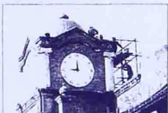
建筑工人在紧张装修
