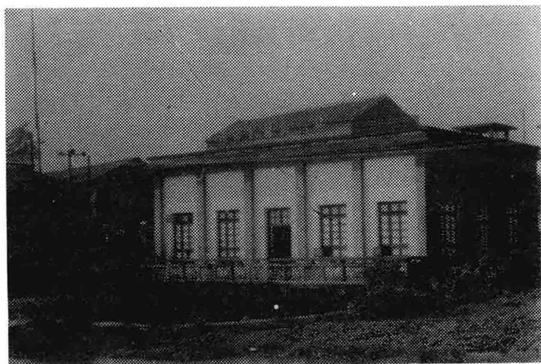
漳田电力排灌站
